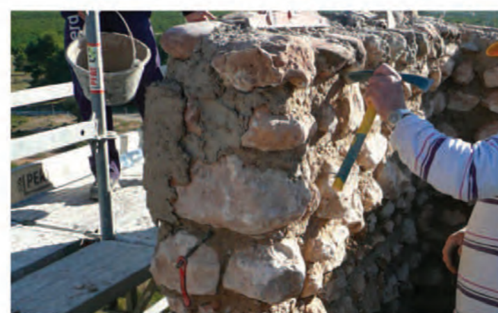
Reconstrucción de merlones
