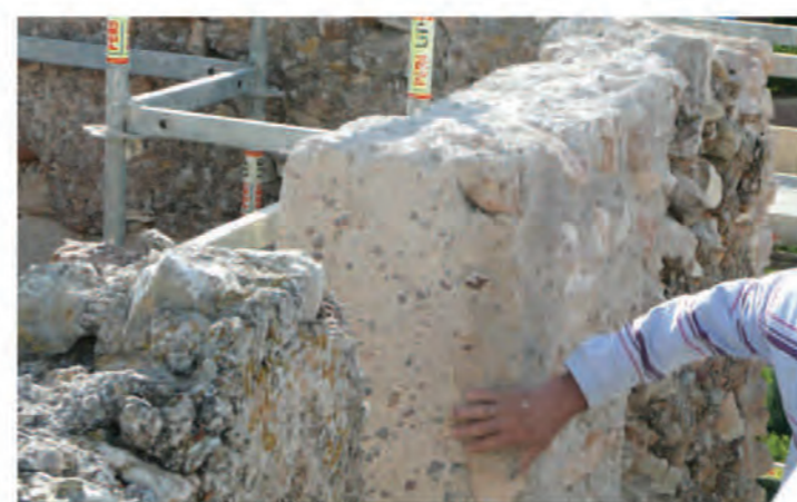
Reconstrucción de merlones
