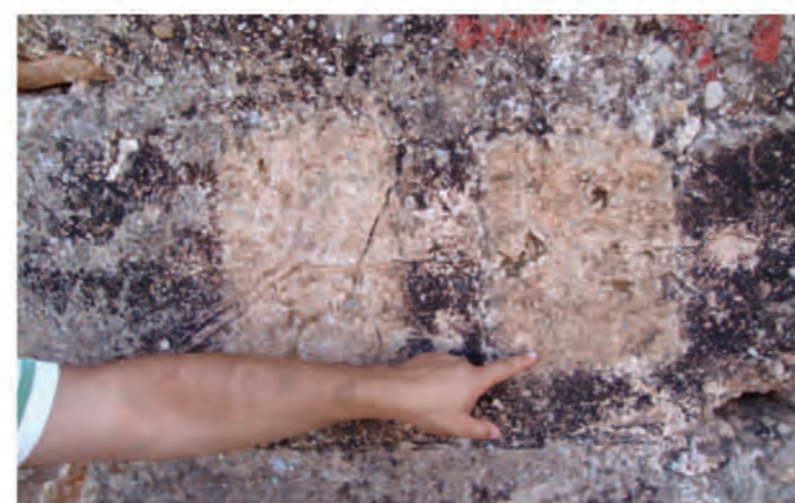
Prueba previa del proceso de limpieza
