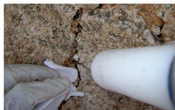
Micro-relleno de fisuras
