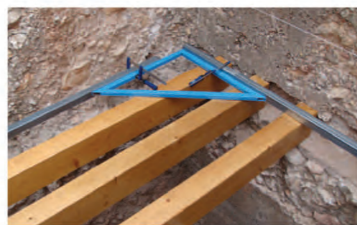
Colocación de los forjados de madera intermedios
