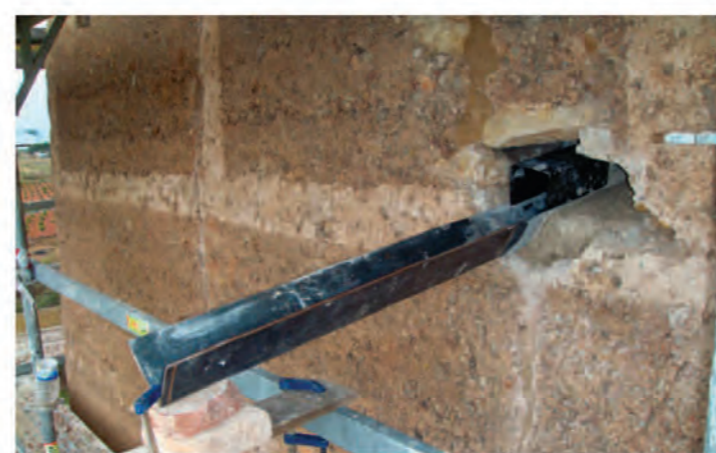
Colocación del nuevo desagüe
